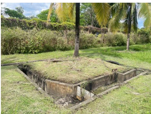
รูปที่ 29 บ่อแยกน้ำ-น้ำมัน
